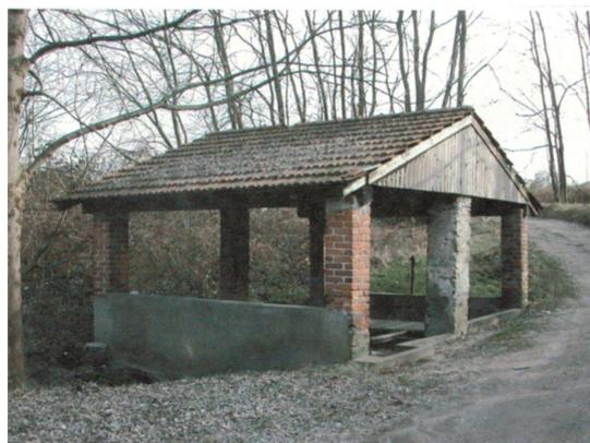
sei colonne in muratura (misure 5,8x 4,6 m) aperto su tutti i lati, copertura a capanna con manto in tegole, la struttura è formata da capriate in legno e frontoni decorativi con assicelle in legno.
